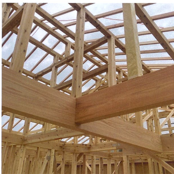
※写真は、建て方当日の写真です。
